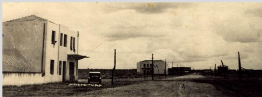
Figura 7 – Em primeiro plano, sede da Prefeitura, (Av. Anhanguera esq. Av. Araguaia). Ao fundo, Edifício Agência dos Correios e Telégrafos (rua 3 esq. com Av. Araguaia). Foto: Eduardo Bilemjian. Fonte: Acervo MUZA|GO.
